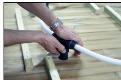
T-styckena trycks och skruvas fast på luftventilerna.
