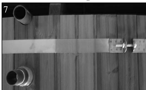
Bild visar anslutning för vedkamin
